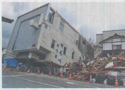
輪島市街で倒壊したビル（3月17日撮影）
