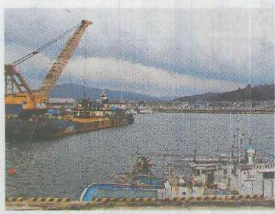
応急復旧で浚渫作業を行った輪島港（3月17日撮影）
