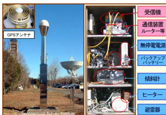
図 2. 電子基準点「つくば 3」(No.960627)の外観及び収納箱内部の機器構成。
