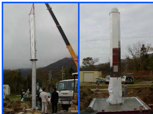
図 3. 02 型電子基準点（二重管構造）設置。
