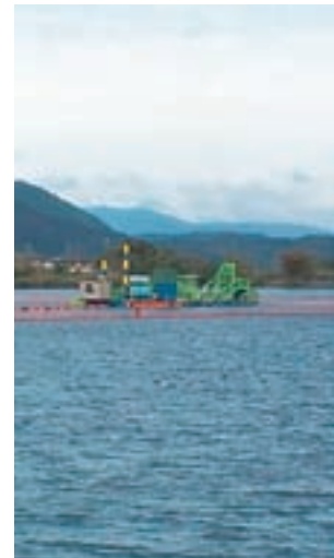
図表5 現場作業の様子（遠景）
