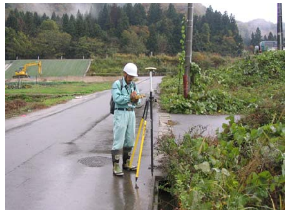
写真4：ネットワーク型RTK-GPS地形測量による簡易な現況を1人作業で観測している状況（地形測量）
