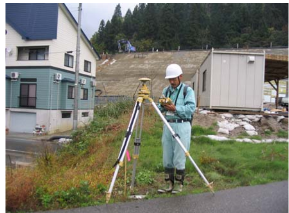
写真3：ネットワーク型RTK-GPS基準点測量の直接観測法による1人作業の観測状況（基準点測量）
