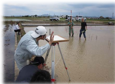
(1) ポイント設置状況
